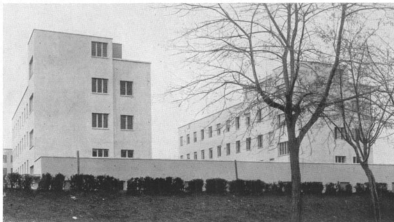
I DUE BLOCCHI DELLE STANZE D'ALLOGGIO VISTI DAL GIARDINO.
